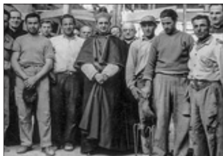
Il 23 gennaio 1955, due settimane dopo l'ingresso nella diocesi milanese l'arcivescovo Giovanni Battista Montini visita il cantiere per la costruzione della chiesa del Cuore Immacolato di Maria in San Sebastiano (oggi intitolata a San Leonardo Murialdo)
