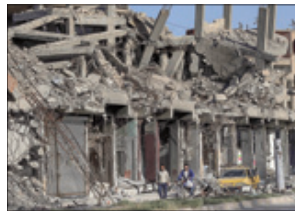
Palazzi distrutti dai combattimenti a Raqqa (Ap)
