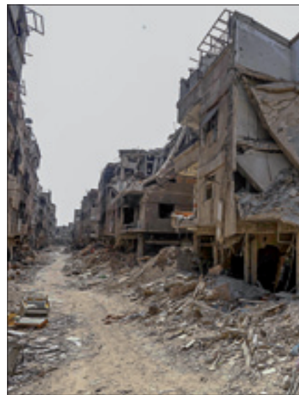
Palazzi distrutti dalle bombe a sud di Damasco (Afp)
