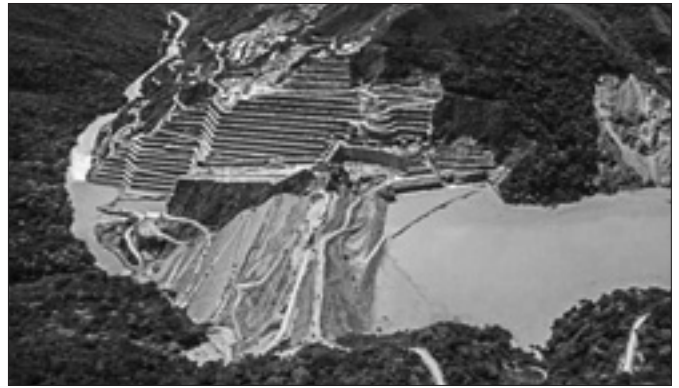
La diga colombiana di Hidroituango
