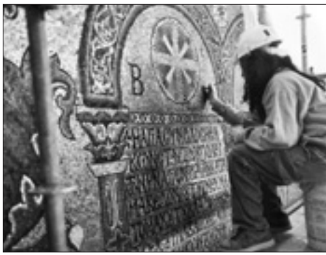
Lavori di restauro nella basilica della Natività a Betlemme
