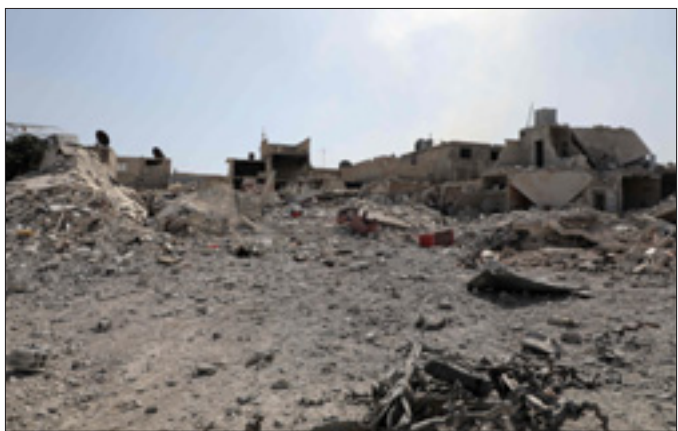
Edifici distrutti a Duma, nell'area del Ghouta orientale (Afp)
