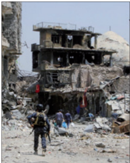
I resti di un quartiere di Mosul
