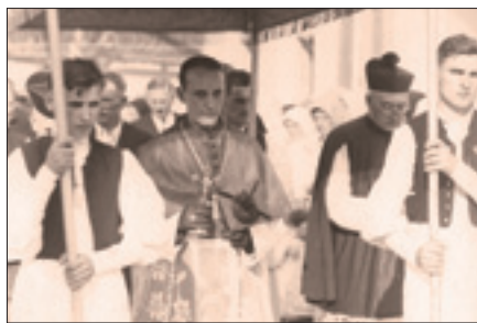
L'arcivescovo Stepinac al congresso eucaristico di Jastrebarsko (1939)
