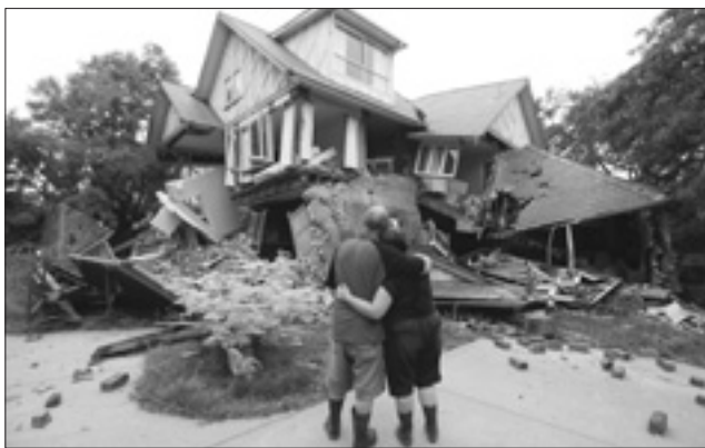
I danni provocati dal terremoto a un'abitazione a Christchurch (Ap)
