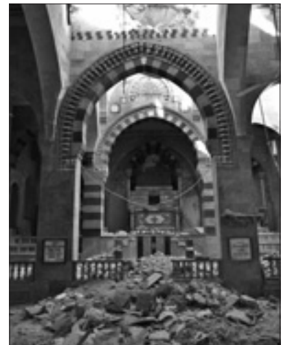
Une église arménienne détruite par les bombardements à Alep
